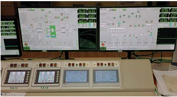
Рис. 2. АРМ оператора и пульт резервного управления ПТК «Неман-Р»
